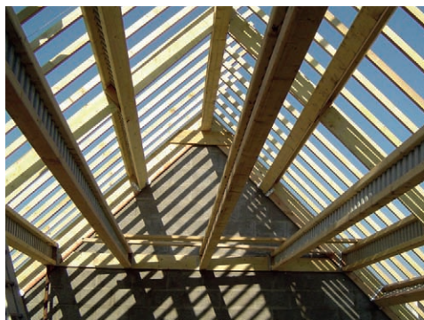
Pannes pour la reprise de la toiture et du plafond, pose sur linder et sabots métalliques
