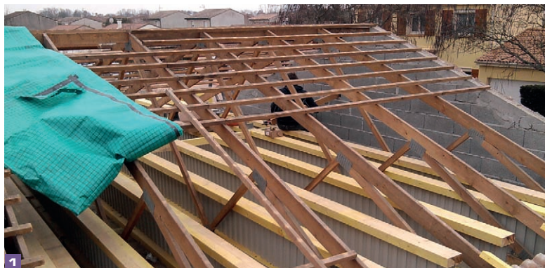
Pose des poutres Nailweb le long des fermettes - Le bâchage permet de conserver l'habitabilité durant les travaux
