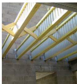
Solivage Nailweb - Pose sur sabots avec entretoises en Croix de St André
