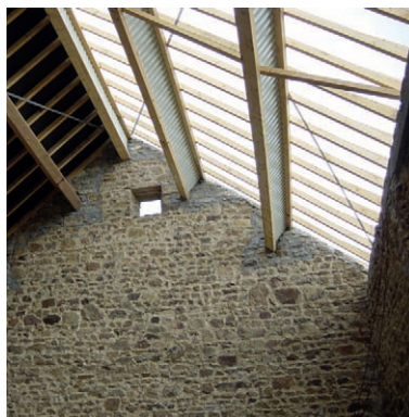
Pannes - Pose déversée - Réhabilitation de l'habitat ancien - Rempannage dans les pierres
