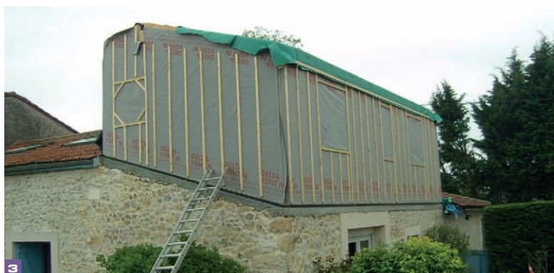
Toiture terminée - Surélévation réalisée grâce à la poutre Nailweb - En attente de bardage
