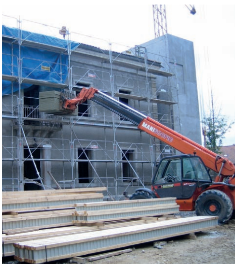
Rénovation d'un bâtiment - Poutres Nailweb manu-portables donc pratiques pour l'accès sur chantier
