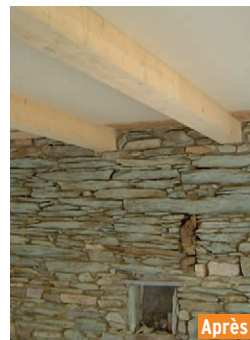
Poutre Nailweb Déco - Entraxe de 120 cm pour la poutre DÉCO pour un aspect de vieil empoutrement. Empoutrement réel de 60 cm, une poutre sur 2 est masquée sous le plafond
