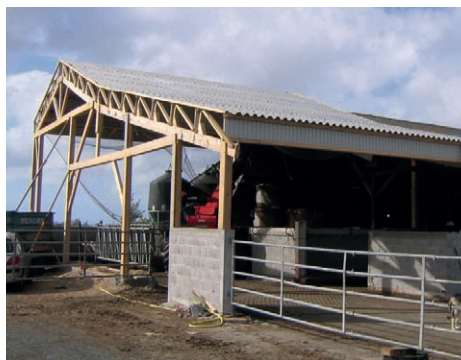
Bâtiment agricole - Pose en pannes - Prolongation de bâtiment - Couverture d'aire d'exercice - Pannes de 7 à 14 m
