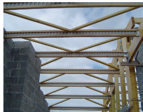
Pose en pannes entre lamellé-collé et maçonnerie sur sabots métalliques avec système de contreventement
