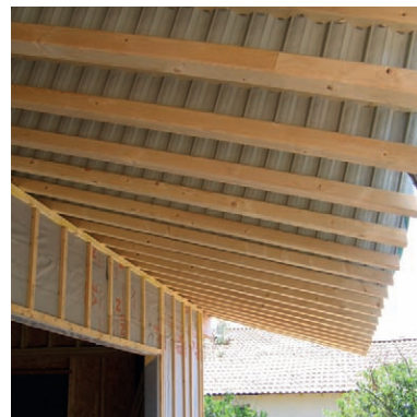
Débords de toit
