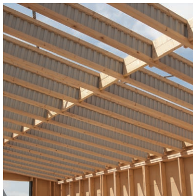
Chevrons sur toiture à faible pente
