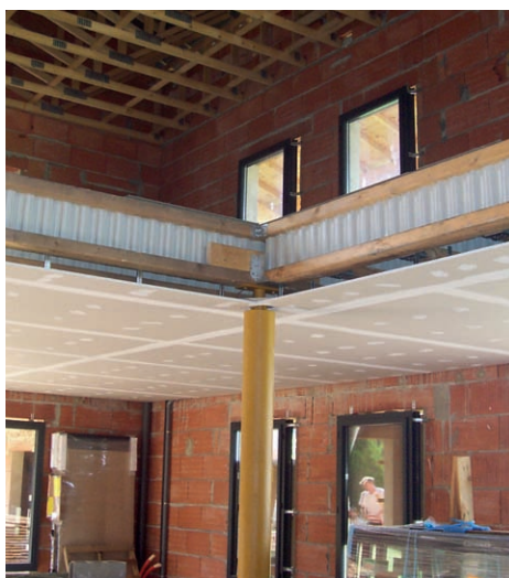
Plancher d'étage - Poutres Nailweb débitées sur-mesure pour chantier rapide en filière sèche
