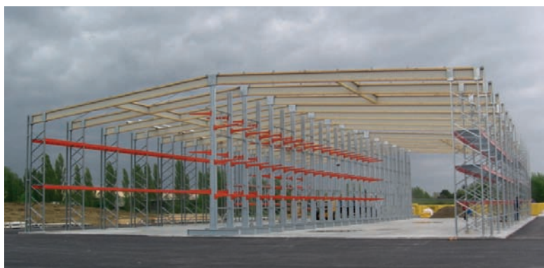
Chevrons posés à fort entraxe sur bâtiment industriel
