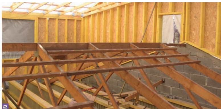
Après pose de l'ossature et de la nouvelle charpente et avant la suppression de l'ancienne structure
