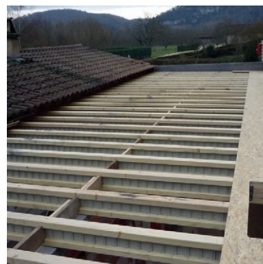
Toit-terrasse en support d'étanchéité
