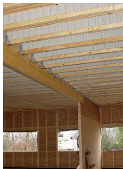
Solivage Nailweb - Pose sur sabots entre lamellé-collé porteur
