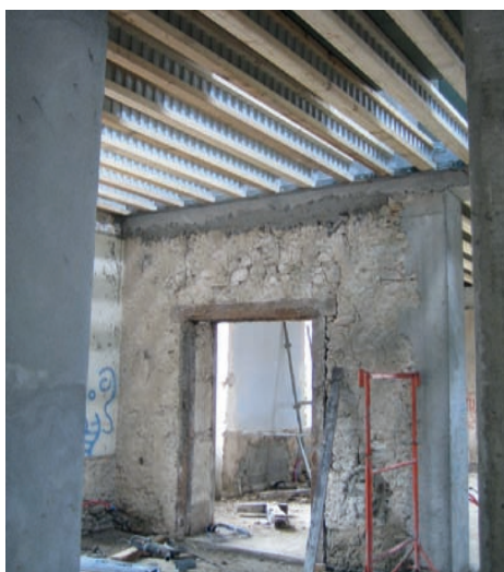
Rénovation d'un bâtiment - Poutres Nailweb manu-portables donc pratiques pour l'accès sur chantier
