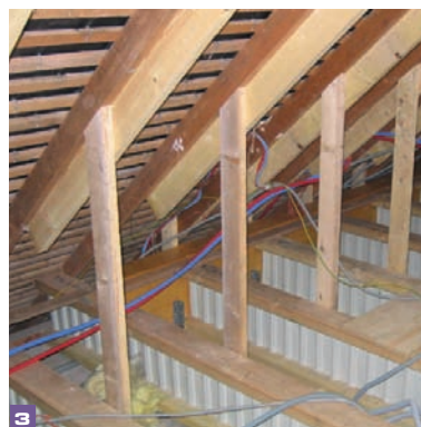
3 Renforcement des fermettes existantes
