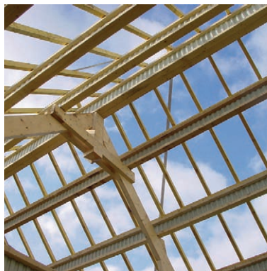
Pannes sur charpente traditionnelle - Pose à l'aplomb avec cale d'appui - Stabilité par feuillard
