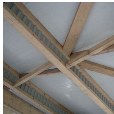
Pose en pannes avec bracons en bois massif et entretoises en Croix de Saint André
