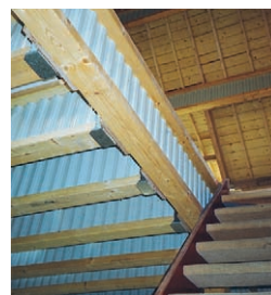
Chevêtre en Nailweb pour trémie d'escalier - Pose sur sabots
