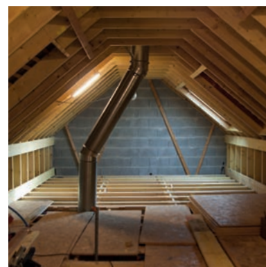
5 AVANT/APRÈS - Création du comble aménageable grâce à la poutre Nailweb
