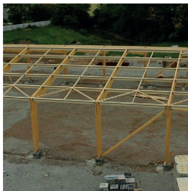
Bâtiment industriel - Pose en pannes entre arbalétriers en lamellé-collé avec entretoises et bracons
