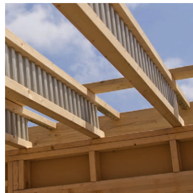
Débords de toit réalisés par membrures hautes
